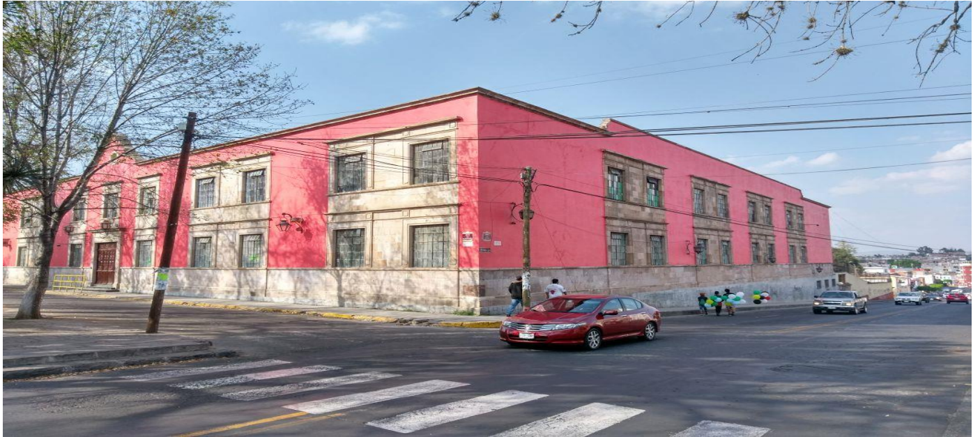
Edificio actual Escuela Primaria Urbana Estatal “Simón Bolívar” Fray Antonio de Lisboa S/N col. Centro Morelia, Michoacán, México.
